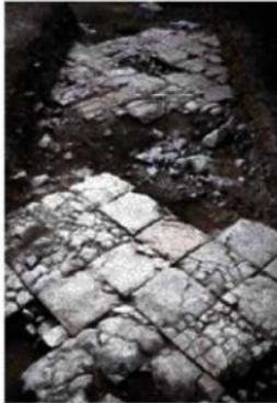
写真1 基礎上面の四半敷きと縁石補修部
