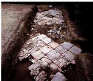
8 方広寺大仏殿跡 東山区正面通大和大路東入る茶屋町 大仏殿の床は、一辺60cmの正方形の花崗岩が斜格子状に敷かれ ていた。建物規模は南北約90m・東西約55mと推定できる。
