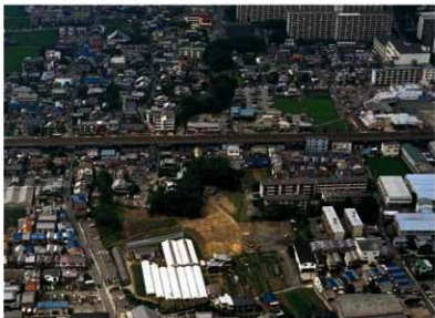
写真1 調査地付近 中央に調査地、帯状の茂みは現存する土塁(南から)
