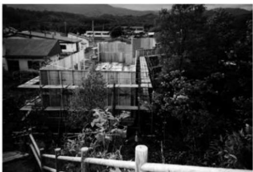
写真 23 ガイダンス施設型枠取付状況
