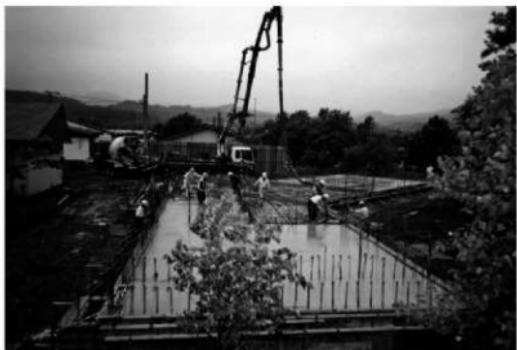
写真 22 ガイダンス施設基礎コンクリート打設状況
