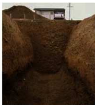
写真2 堀9・10の断面（北から）
