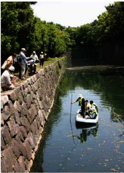
写真1 ボートからの石垣観測(西から)
