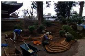
写真4 築山の修理 (B区 北東から)
