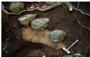
写真5 階段石の設置 (B区) (写真2・4・5 京都市文化財保護課提供)
