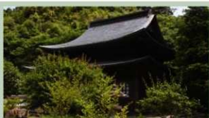
①洞春寺観音堂(重要文化財) 大内持隆が永享2年(1430)に建立した仏殿です。大正年間に毛利元就の菩提寺である洞春寺へ移築されました。
