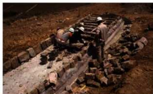
写真7 園路の整備 階段を設置した。
