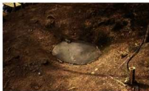
写真5 20号墳 天井部の隙間を土とコンクリートで封鎖した。
