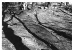
園路および階段設置状況
