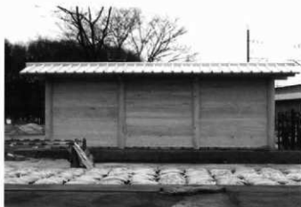
掘立柱塀全景
