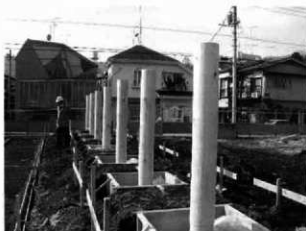
掘立柱立柱状況
