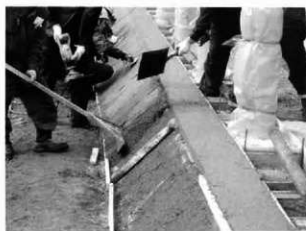
基壇法面施工
