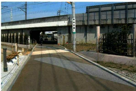
中樞地区東面塀・東門
