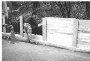
土留壁設置状況
