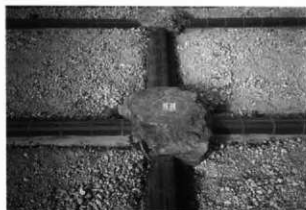
礎石及び壁表示施工状況
