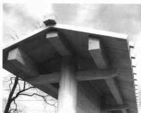
板屋根内部見上げ
