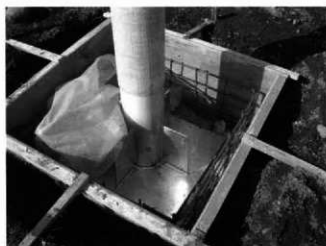
掘立柱据付状況
