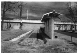
区画溝及び掘立柱塀整備状況
