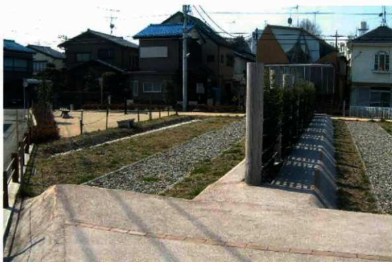
中樞地区南面塀
