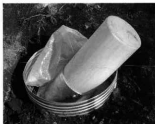
斜め建て支柱据付状況
