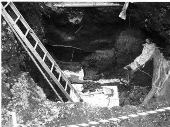
図 3-4 平成 19 年 2 月 20 日 溝道構下部地山部分における排水管取り付け穴位置確認
