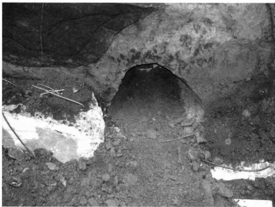
図 3-5 平成 19 年 2 月 20 日 溝道構下部地山部分における排水管設置穴の掘削状況
