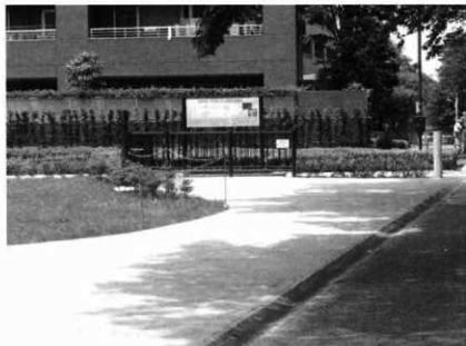
図 5-1 入口広場舗装整備状況
