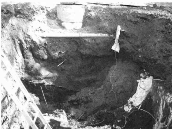
図 3-3 平成 19 年 2 月 19 日 整備工事に伴い既設人孔西側で北辺溝遺構が検出
