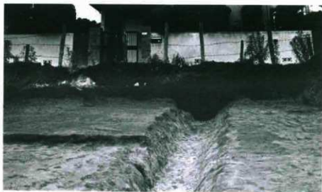
SD 18 溝跡土層断面A~A' (西から)
