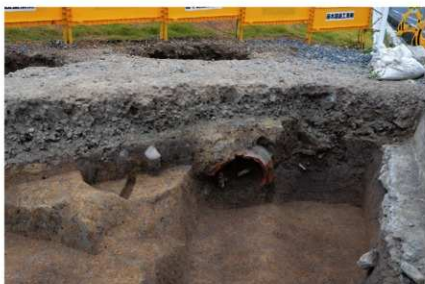
SD03・SH05 北壁断面 (南から)
