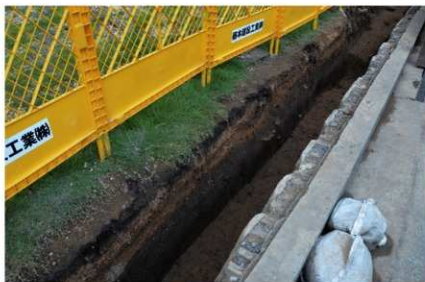
SD08 北壁断面 (南西から)
