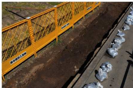
SH02 検出状況 (南西から)
