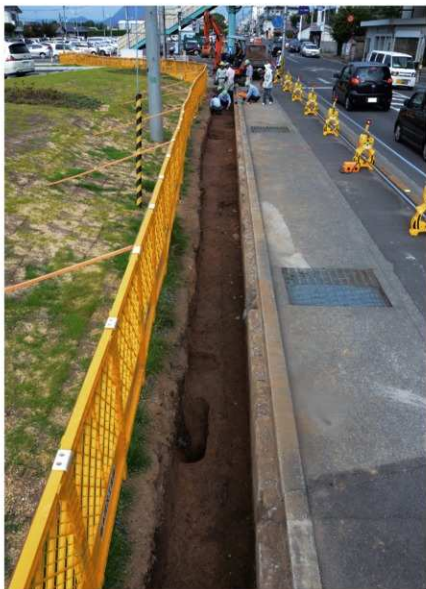
調査区西側検出状況 (西から)
