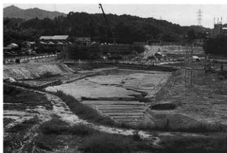
1 調査区全景D区(北から)
