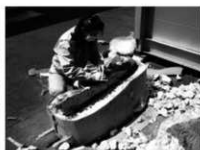
Fig.37 ウレタン解体作業
