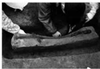
Fig.30 周辺土の除去作業
