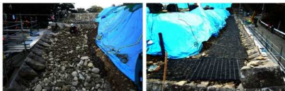
第 20 図 石垣裏込めの修復状況 (左: 伝統工法による施工、右: 一部施行した現代工法)
