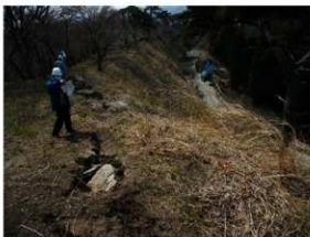
第 2 図 史跡岩切城跡の被災状況
