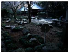
第 1 図 経ヶ峰伊達家墓所の被災状況
