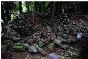
第10図 西門石垣の崩落状況
