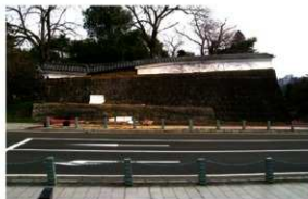
第 14 図 大手門北側土塀の被災状況 (1)
