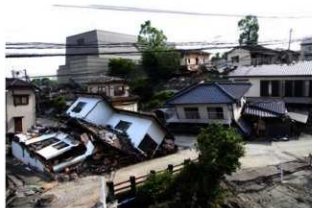
図 1 熊本県益城町における被害状況
