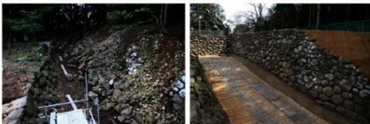
第18図 西門石垣の崩落状況（左）と復旧状況（右）
