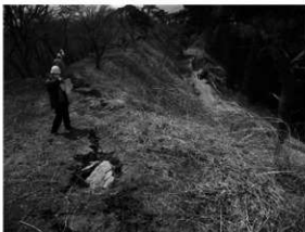
第 2 図 史跡岩切城跡の被災状況
