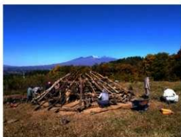
図4 竪穴建物づくり（山梨県北杜市）
