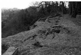
第12図 本丸東側崖面の被災状況
