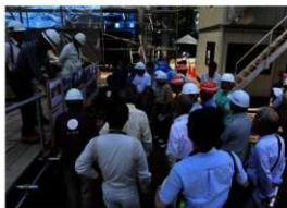
図10 修復現場公開（木山神宮境内/本殿）
