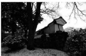
第15図 大手門北側土塀の被災状況(2)
