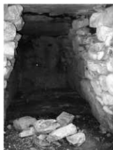
第6図 法領塚古墳の被災状況
