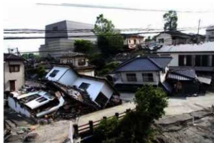
図 1 熊本県益城町における被害状況
