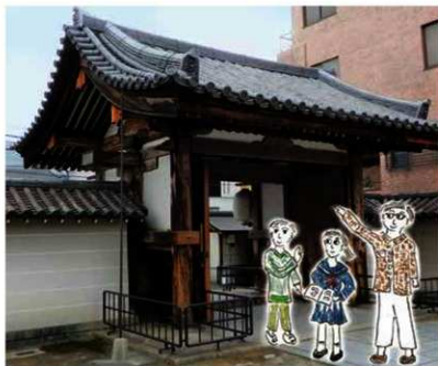
写真3 東寺北総門の南側屋根 軒平瓦に鎌倉時代の瓦も使用されている。(イラスト：上村和直)
