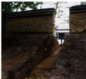
8 史跡醍醐寺境内 伏見区醍醐東大路町 奈良街道に面した西築地を断ち割っての調査。江戸時代後期以降に造られた土塼は、室町時代の土塁の上に築かれていた。
