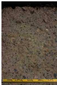
写真2 路面の礫敷き
