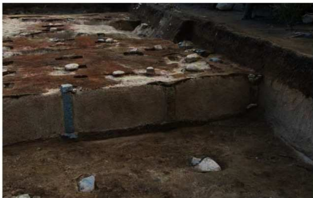
写真1 鳥羽・伏見の戦いでの被災面と蠟燭基礎(西から)
