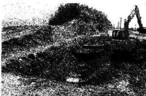
写真 60 末広開外側堤防掘削状況（西から）
