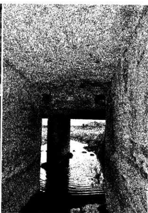
写真 44 末広開西三枚戸樋門の通路内部
