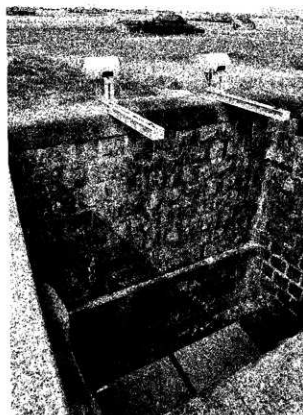
写真 49 未広開二枚戸樋門の招戸設置面（東から）
