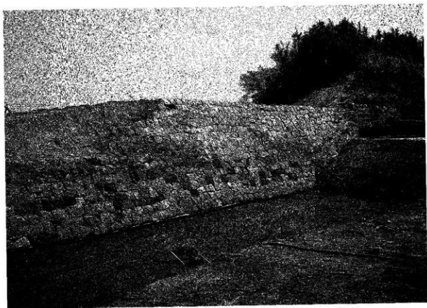
写真 67 末広開内側堤防（南西から）
