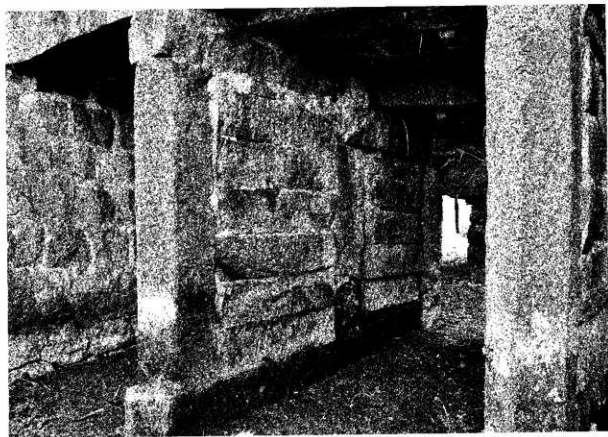
写真 41 末広開東三枚戸樋門通水路（北から）
