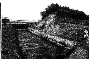
写真 74 水路工事掘削状況
