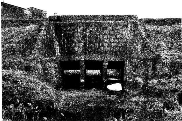
写真 40 末広開東三枚戸樋門（北から）
