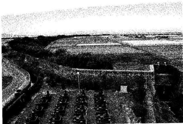
写真 30 末広開瀬受堤防（東から）
