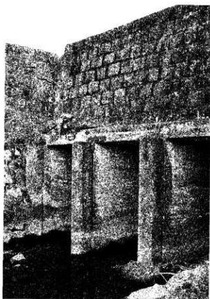
写真 43 末広開西三枚戸樋門通路（北から）
