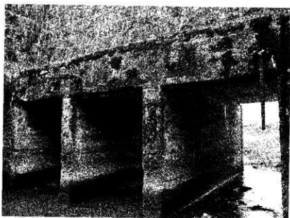
写真 37 末広開西三枚戸樋門招戸設置部分
