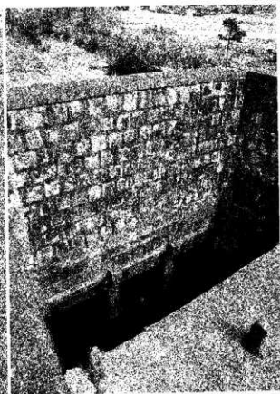
写真 36 末広開東三枚戸樋門の招戸設置面
