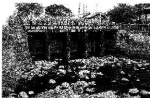
写真7 新内井樋（西から）
