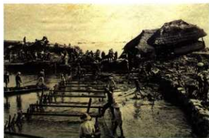
写真 2 大正 3 年潮害の被害状況
