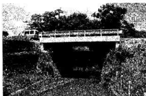
写真 16 明丑開樋門海側（東から）
