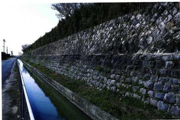
末広開港受堤防（東から）
