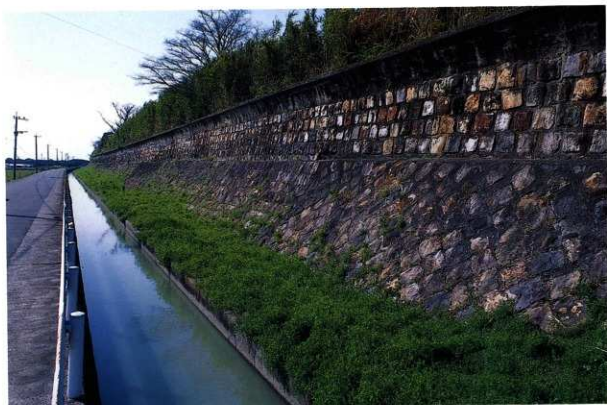
明丑開瀬受堤防（東から）
