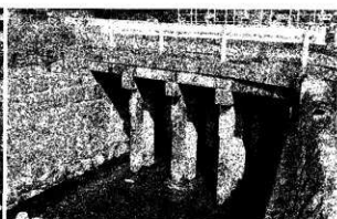
写真8 新井樋（西から）
