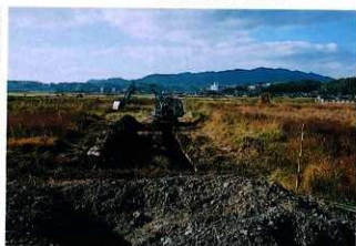
8 12トレンチ掘削状況(東から)
