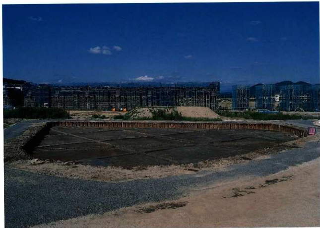
1 調査Ⅱ区全景 (Ⅲb層上面検出時)
