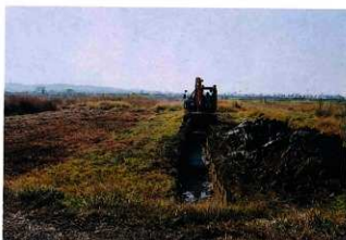
6 11トレンチ掘削状況(北から)
