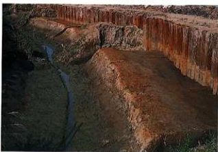
8 14区の畦畔状遺構（東より）
