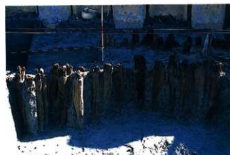
3 杭列2群側面 (西より)
