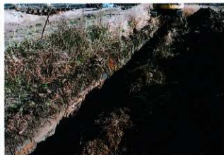
6 57トレンチ掘削状況(西から)
