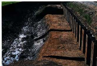
4 12区の畦畔状遺構（東より）
