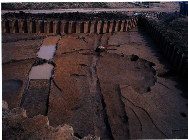
2 S033・34完掘状況 (南から)
