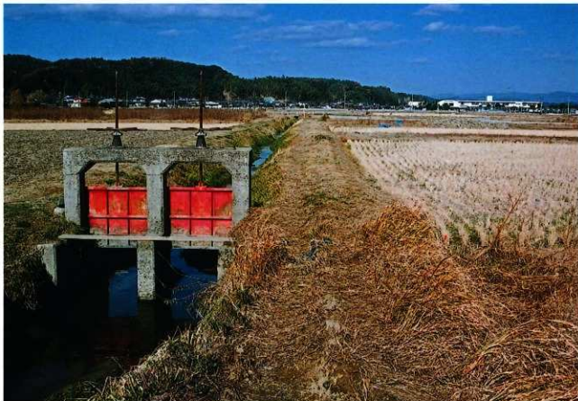
1 調査地西側水路（南から）
