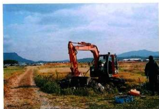
1 1トレンチ掘削状況（東から）
