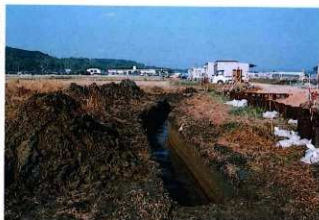
2 7トレンチ掘削状況(南から)
