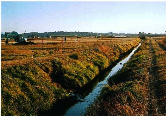
2 調査地西側水路（北から）
