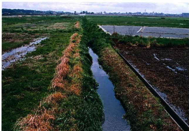
1 中央水路（北から）
