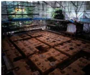
6 特別史跡・名勝 鹿苑寺境内(金閣寺) 北区金閣寺町 江戸時代に建てられた鹿苑寺方丈の解体修理にともなう調査で、室町時代前半に足利義満が造営した北山殿に関する建物の礎石や柱の抜き取り穴が見つかった。
