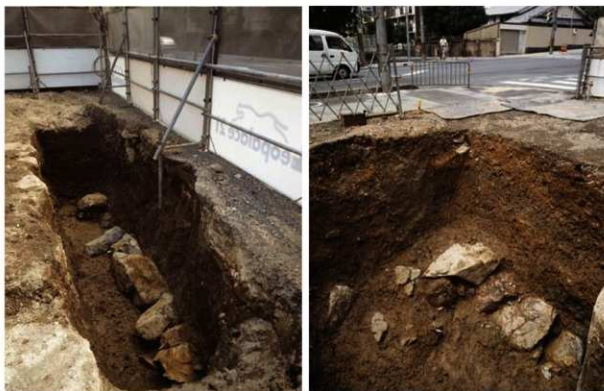
立売通と豊後橋通交差点の石垣 (3の調査)
