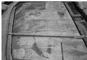
C9区北半部全景 (南から)
