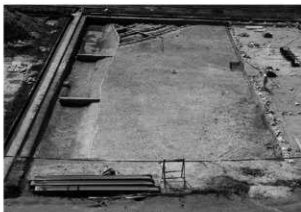
E14区調査区全景（東から）
