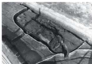
SHf12 全景 北西から
