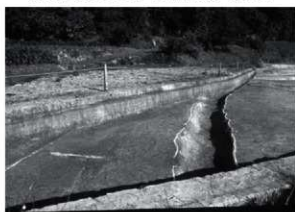
C20区 SDd052 掘削状況 北西から
