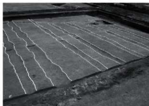
E17N区 SDd046・072~078(左から)完掘状況 南から
