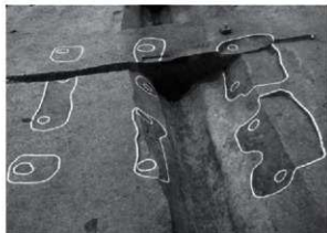
B18区 SBd14 検出状況 南から
