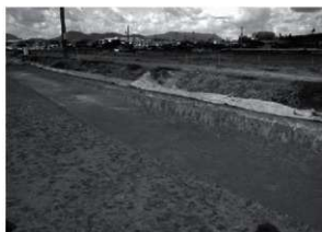
H19 区北壁 土層断面 東から
