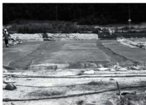
F17区 SDd041(左)・044(右)完掘状況 西から
