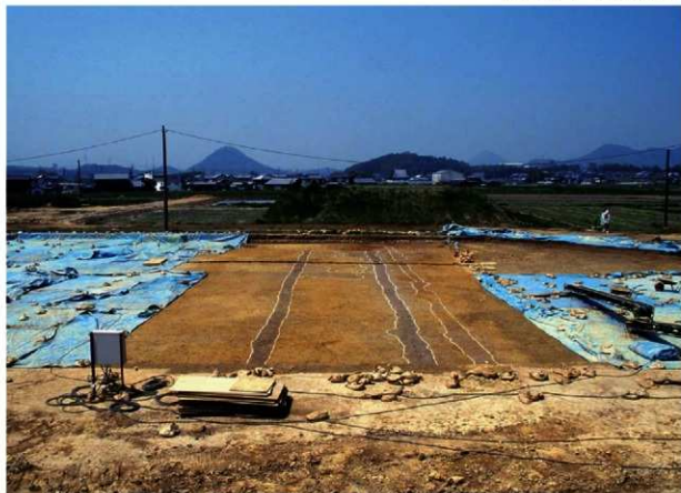
SDd041・042・044 全景 西から
