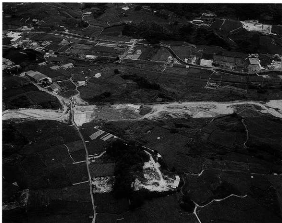
1. 調査区近景 飛鳥川を望む (南から)
