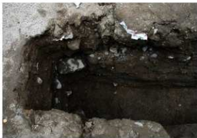
写真4 試掘 T2 北壁地割れ確認状況 (南より)
