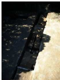
写真3 T2 完掘状況（北東より）
