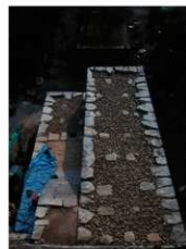
写真5 修理後状況（北より）
