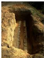
写真1 史跡外 T1 土堀基礎石垣検出状況 (西より)
