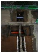
写真3 T2～9 完掘状況 (東より)
