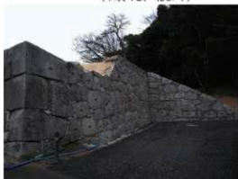
写真9 修理後状況（南東より）
