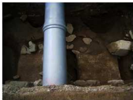
写真4 T8 完掘状況 (北より)
