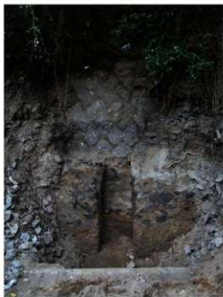
写真7 T7 完掘状況 (東より)
