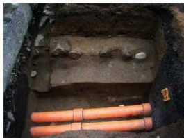
写真7 T9SD2 検出状況 (西より)
