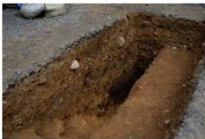
写真4 8次1区南側地山切土状況(北西より)
