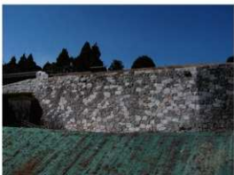
写真16 修理後状況(南東より)
