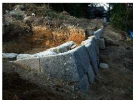
写真4 史跡外 T4 土堀基礎石垣検出状況 (南より)
