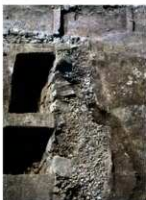
写真3 1次II区石垣2東部(東より)
