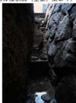
写真8 掘土手及び内堀確認状況（4次T7、東より）
