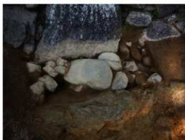
写真3 T1 北端石垣根固め確認状況 (南より)
