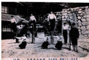
写真11 黒門西石垣古写真（南西より）
