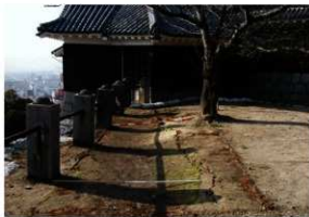
写真6 試掘 T3 調査前地割れ・地盤沈下状況 (東より)
