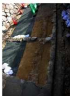
写真4 T2 西側完掘状況 (北西より)
