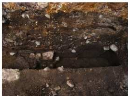
写真8 擁壁 SK1 完掘(土塚基礎検出)状況(南より)
