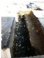
写真7 T21 調査状況 (西より)
