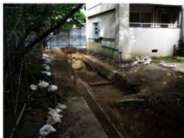
写真1 T3 調査状況 (南より)
