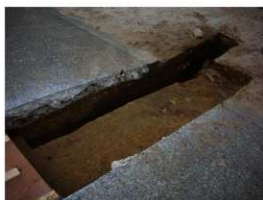
写真7 T5 北側完掘状況 (東より)
