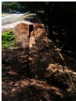
写真8 T8 完掘状況 (北より)
