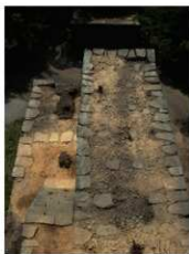
写真3 解体前状況（北より）
