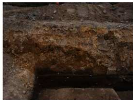
写真4 擁壁 馬場～馬場土手部分完掘状況 (南より)
