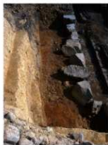
写真5 解体後状況（北石垣、西より）
