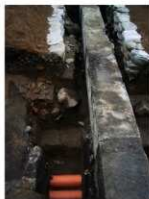
写真8 T9SD1・2 交差部分検出状況 (西より)
