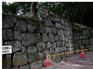
写真 1 解体前状況 (南東より)
