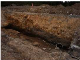
写真3 擁壁 完掘状況 (南東より)
