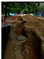
写真 11 工事立会栗石層確認状況 (西より)
