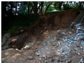
写真10 T9 完掘状況 (北東より)
