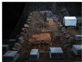
写真4 解体後状況（南西より）
