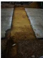
写真1 T1 完掘状況 (南より)
