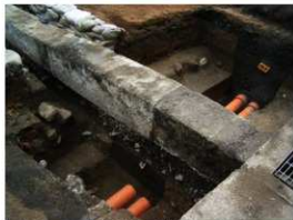
写真6 T9 完掘状況 (北西より)
