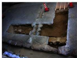
写真6 T4 東側完掘状況 (北東より)
