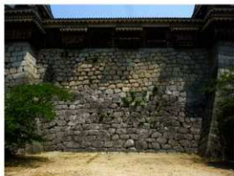
写真7 本壇東石垣にみられる石垣改修痕 (東より)
