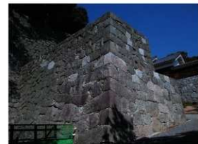
写真6 修理後状況（南西より）
