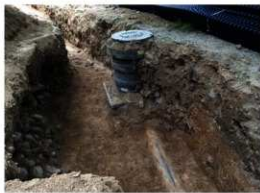
写真 12 工事立会栗石層確認状況 (東より)
