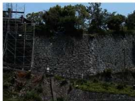
写真15 解体前状況(南より)
