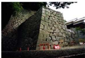
写真2 解体前状況（南西より）
