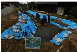
北部作業状況
