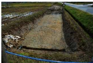
南部掘削終了 (北西から)
