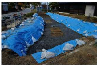
北部掘削終了（南から）
