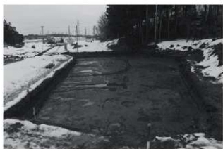
東区 完掘状況（東から）
