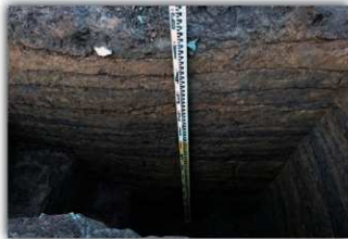
▲ガラミドウで発見した版築（地盤改良工事）の様子
