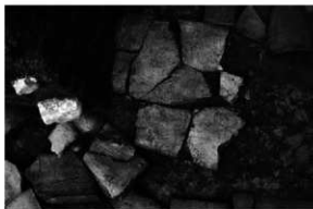
8 中門 SB216 中門 1-2 壺地業 石敷き1層目(西から)
