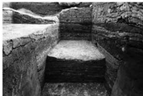
4 金堂6区旧トレンチ SB217基壇・掘込地業 版築断面(北から)
