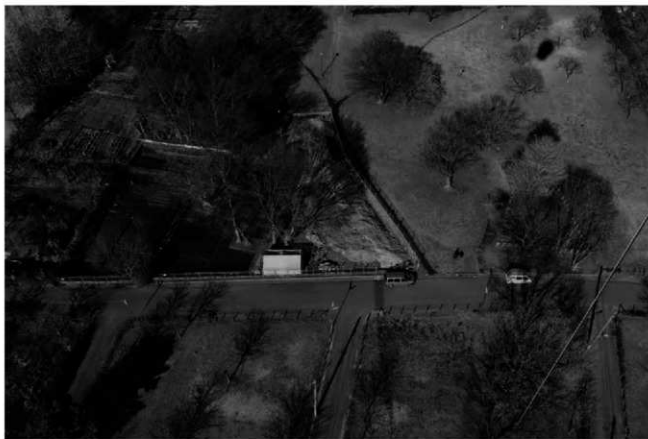
5 塔1・塔2 全景(南から)
