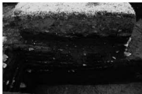
3 講堂 3-2 区旧トレンチ SB218A 版築断面 (西から)
