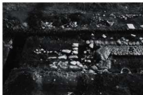
3 昭和31年度金堂調査 北面階段 (北から)
