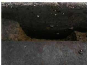
SD425 新断面 (北から)
