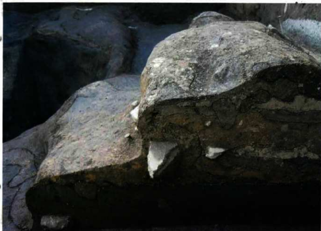
伽藍中樞部区画施設（北西地区）築地塙版築の断割り断面（東から） ※黒色土を基底部に据え、ロームと白色粘土の互層で積上げている。 部分的に瓦片が混入する。
