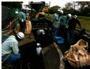
ガス工事立会作業風景（北西から）
