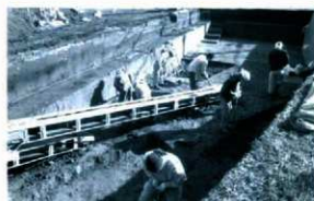
作業風景 (西から)
