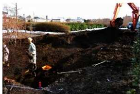
第194図 表土掘削状況（北西から）
