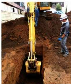
第121図 地下防空壕天井部掘削(西から)
