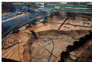
遺構検出状況(調査区中央部 北東から)
