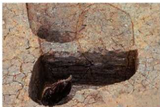
C区第1面 P60土層断面(南から)
