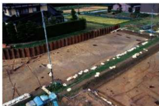
完掘状況(調査区東部 南西から)
