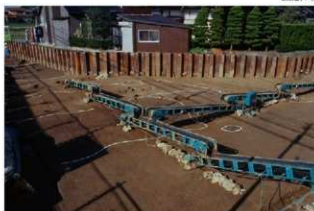
遺構検出状況(調査区南西部 南西から)
