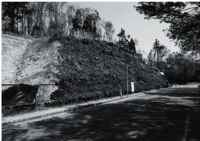
調査区現況 (着手前)
