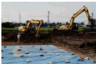
1区表土の重機掘削
