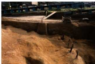
4-Ⅲ区 SX06 土層断面と杭列 (北から)
