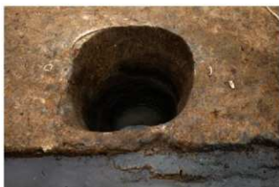
4-I区 SE02 (北から)
