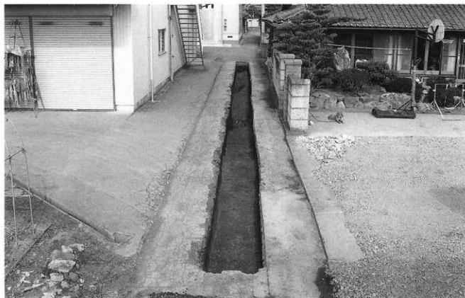
調査区北部全景（南から）
