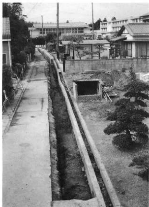
B工区 調査区全景（東から）
