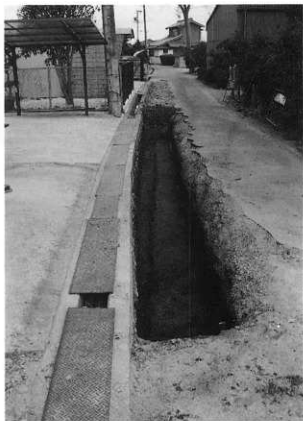
A工区(2) 調査区全景（西から）
