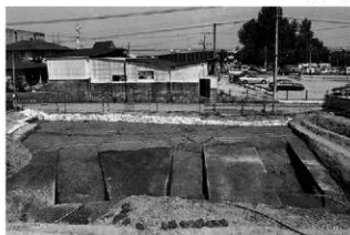
完掘状況 (西から)
