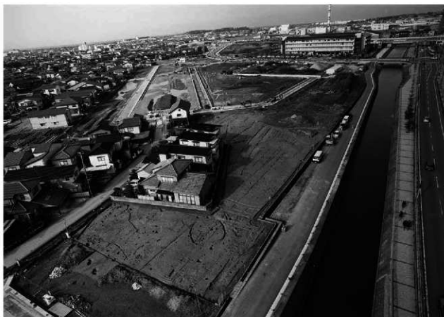
D3区全景 (南東から)
