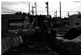
B区表土除去作業（東から）
