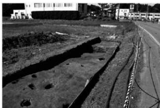
B区 SD6 完掘状況 (南西から)
