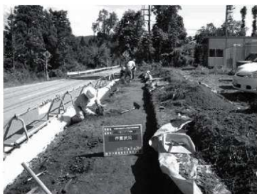
第3図 作業状況
