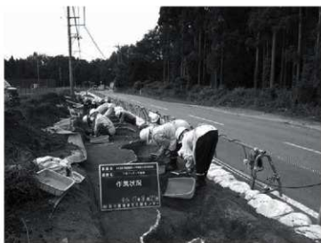
第3図 作業状況
