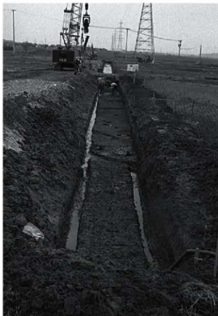
1～3区 完掘状況（北東から）
