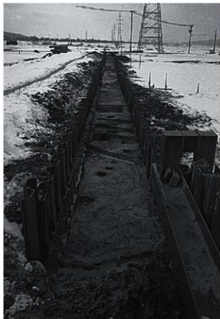
7～14区 完掘状況（北東から）
