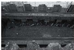
I区 杭列 (南東から)
