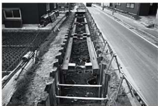
IX区 突掘状況 (北東から)
